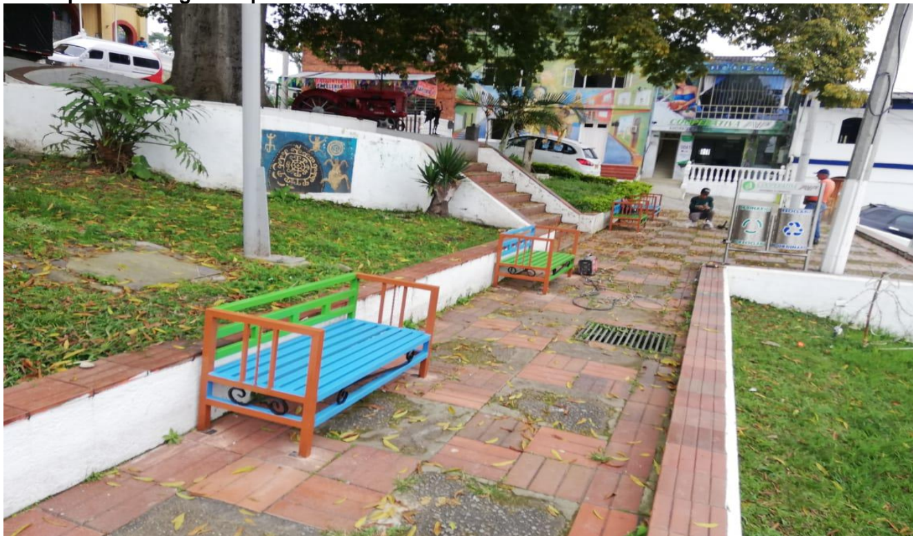
Instalación de cuatro (4) bancas en el parque principal de Pradilla
