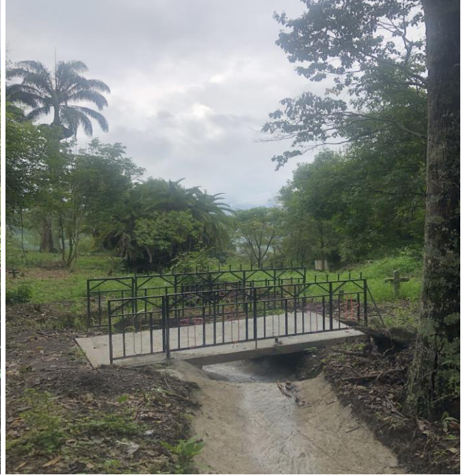
Puente de acceso con zanja reforzada en donde se reciclaron las rejas
